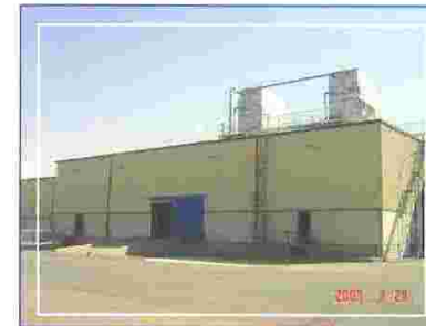
غرفة الضواغط المركزية
