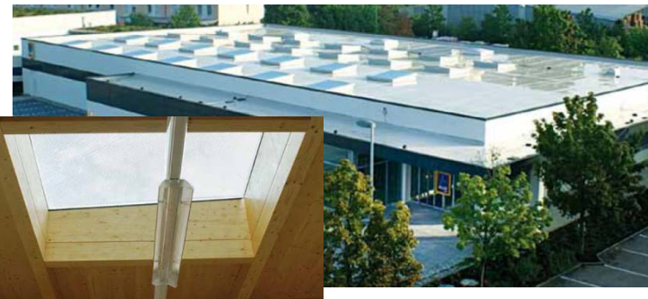
Natürliche Beleuchtung durch spezielle Oberlichter bei ALDI Süd in Rastatt
